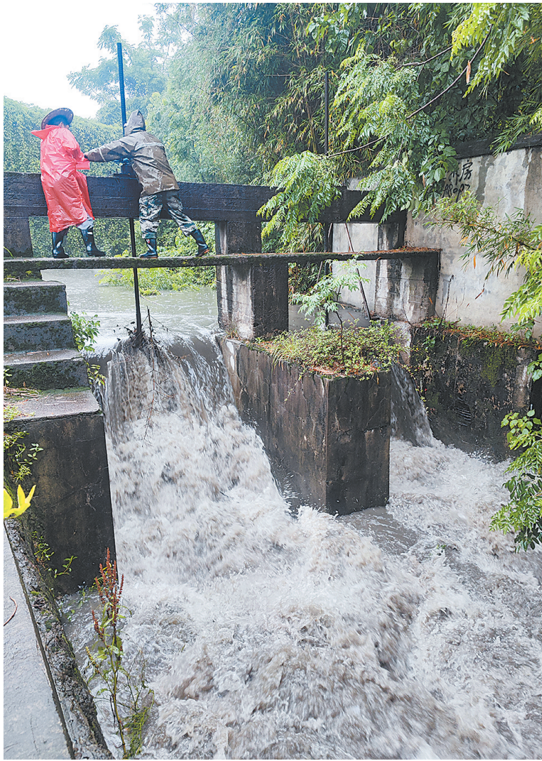
昨日,巍山镇仙学塘村莘塘下村干部在水渠上旋转螺旋杆开闸排水。 通讯员 王瑶花
