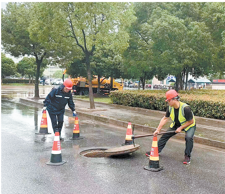
昨日,应急工作人员对高考考点周边排水设施进行隐患排查。
